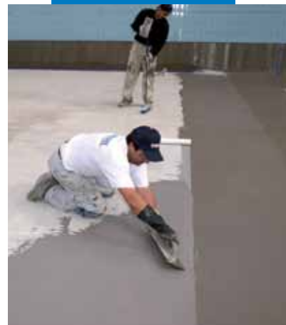
Гидроизоляция бассейна с применением Mapelastic
