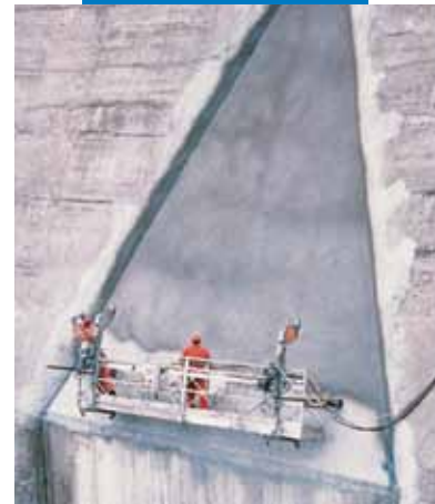
Нанесение Mapelastic на дамбу распылением
