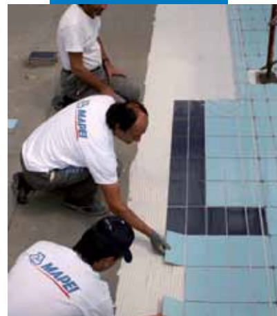
Укладка керамической плитки на Mapelastic в бассейне
