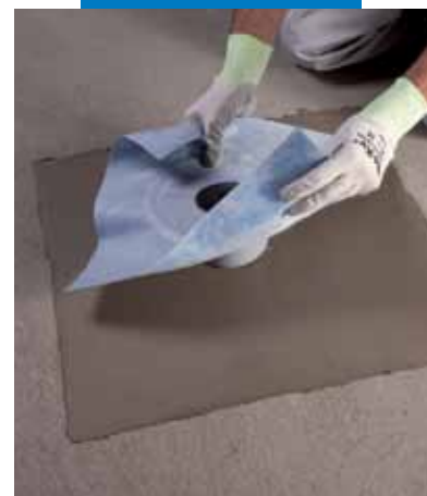
Установка Вертикального Дренажа на Mapelastic
