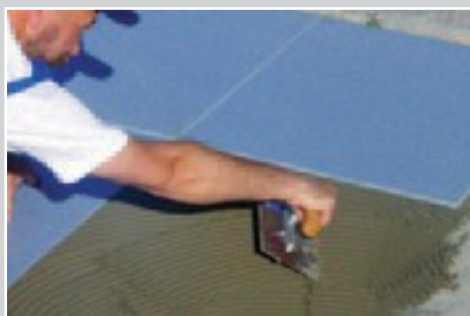
Укладка крупноформатной плитки на клей SUPERFLEX K77
