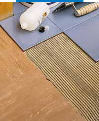
Укладка нового покрытия поверх существующего из ПВХ
